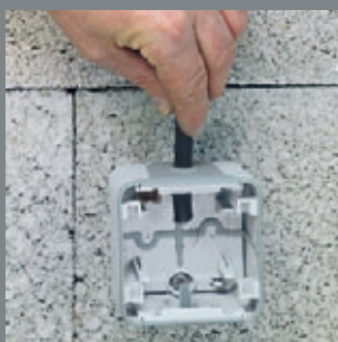
2/ Prostrčte kabel přes průchodku
