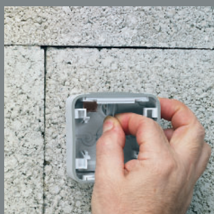
1/ Otvor uděláte zatlačením pomocí zakončovacího nástroje
